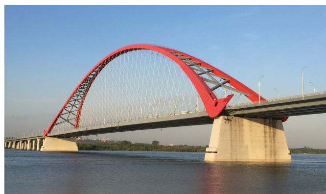
Бугринский мост в Новосибирске
